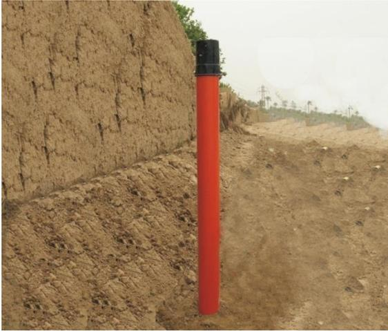
الشكل (7) نقطة فحص ثابتة (Test Point)
