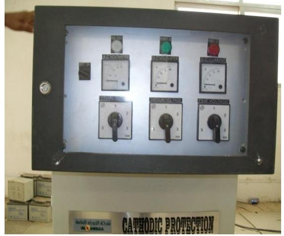
الشكل (6) لوحة السيطرة لتنظيم فولتيات الخرج لمجهز القدرة
